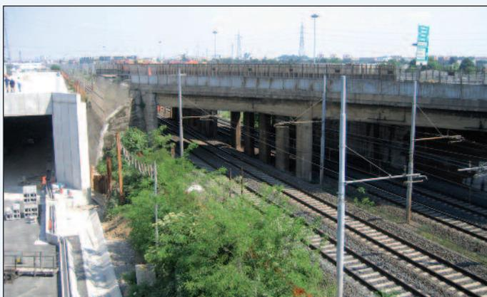
Figura 2 - Il viadotto autostradale preesistente con accanto la nuova galleria AV già realizzata
