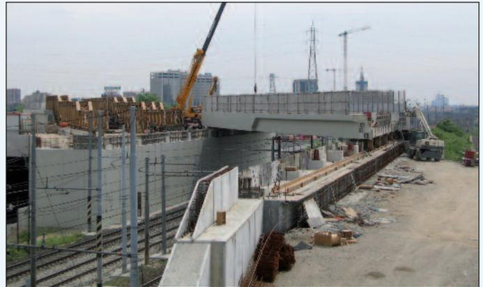
Figura 15 - Il primo solettone è stato traslato, il secondo è pronto per il varo
