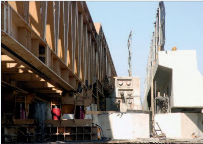
Figura 13 - La fase finale di spinta del secondo solettone; in primo piano i pattini idraulici
