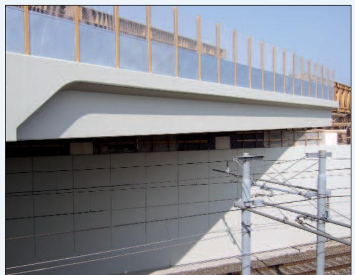
Figura 7 - Il dettaglio delle travi di bordo del solettone
