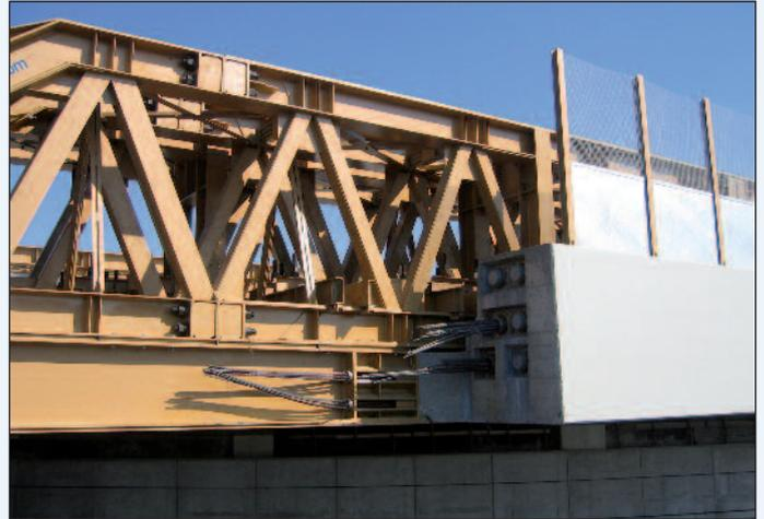
Figura 11 - Il dettaglio degli avambecchi e del loro collegamento al solettone
