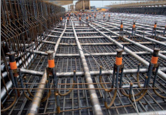
Figura 10 - Gli elementi di ancoraggio dei tralicci di varo nel solettone
