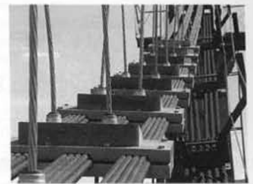
写真-5 新設の吊りケーブル構造
