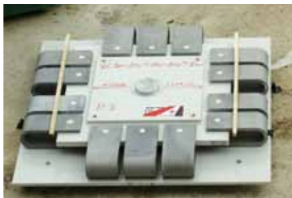
Figura 15 - Un ritegno elasto-plastico bidirezionale per le pile fisse del Tammaro I
