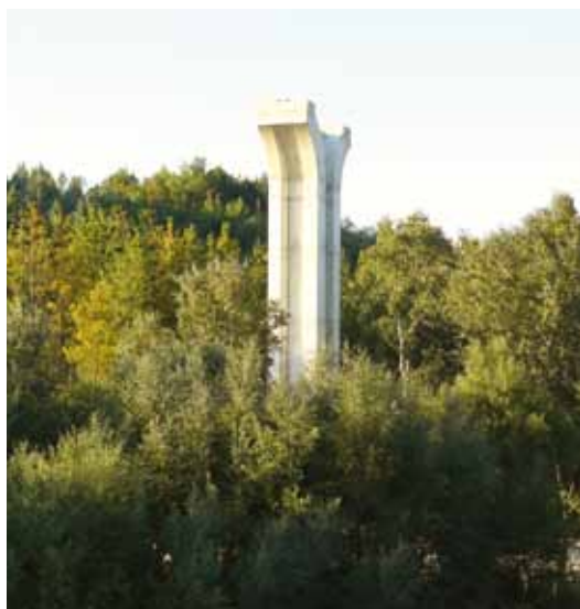
Figura 12 - La pila in sponda destra del Tammaro II
