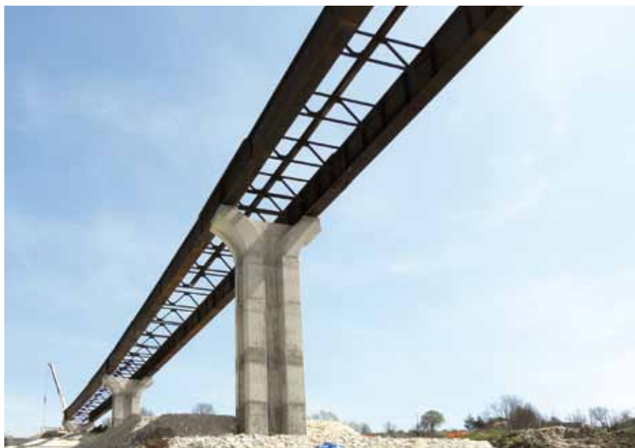
Figura 13 - Pila e pulvino del Tammaro II
