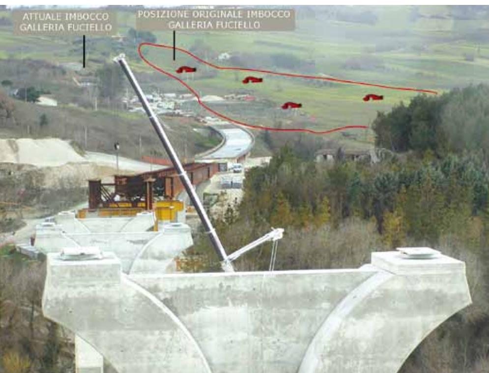
Figura 11 - Panoramica del Tammaro I (sul fondo, completato) e Tammaro II (in primo piano, in costruzione). I due viadotti sono separati da un breve tratto di rilevato. In alto in destra la frana evitata con la variante
