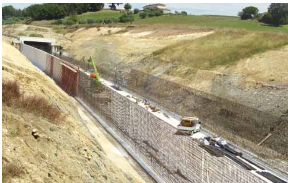
Figura 2 - Dissesti nelle "argille varicolori" avvenuti su scarpate anche con pendenze ridotte ( h/b=1/2 )
