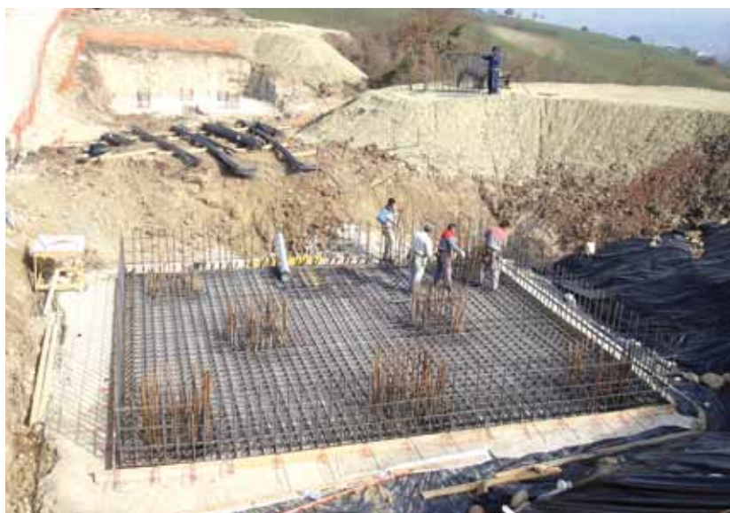
Figura 20 - Armatura del plinto e collegamento ai pali. Si noti l'ultimo palo centrale senza ferri di collegamento per consentire la predisposizione alla prova di carico
