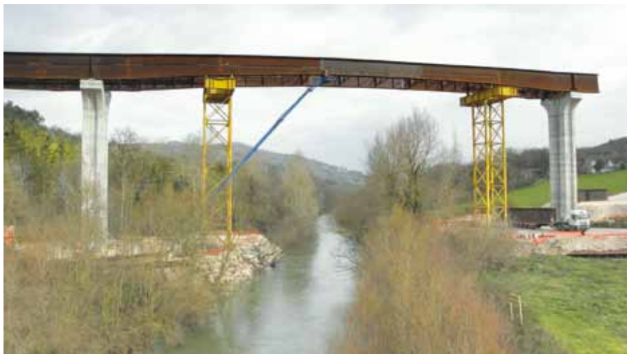
Figura 16 - Operazioni di serraggio dei bulloni sul concio di chiusura del Tammaro II
