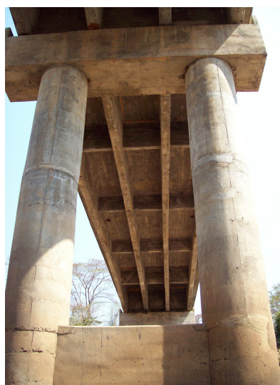
Figura 4 – Le strutture portanti del ponte
