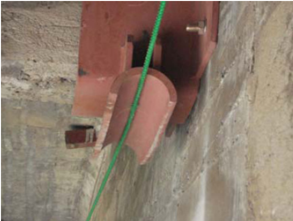
Figura 11 – La sella di deviazione appoggiata ai diaframmi trasversali (Cavi Tipo B)
