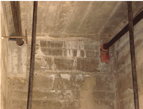
Figura 12 – I dispositivi di deviazione sui diaframmi di pila
