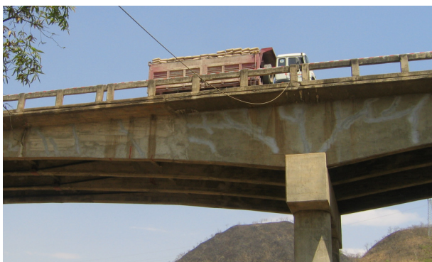
Figura 14 – Prospetto della trave con le fessure iniettate
