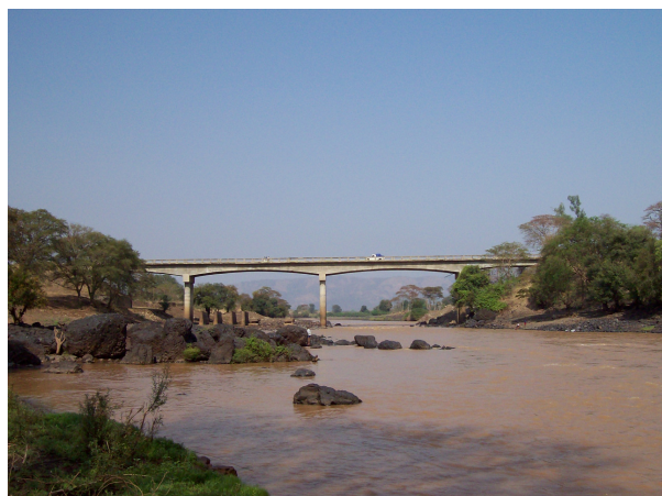
Figura 1 – Il ponte sul fiume Gibe
