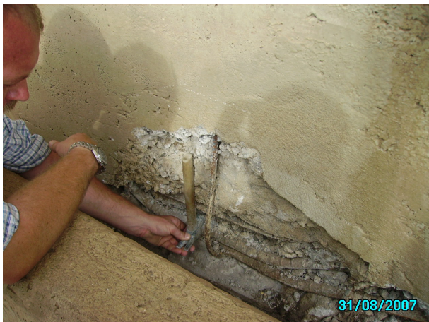
Figura 5 – Espulsione del copriferro per eccessiva compressione
