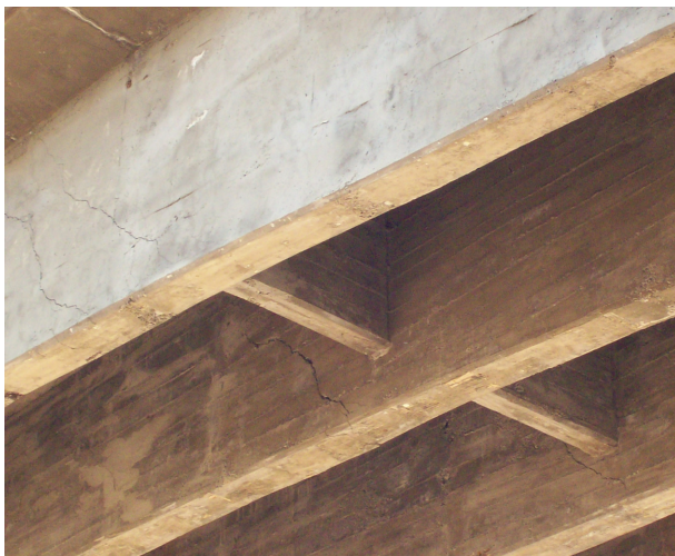
Figura 6 – Le fessure sulle travi d'impalcato
