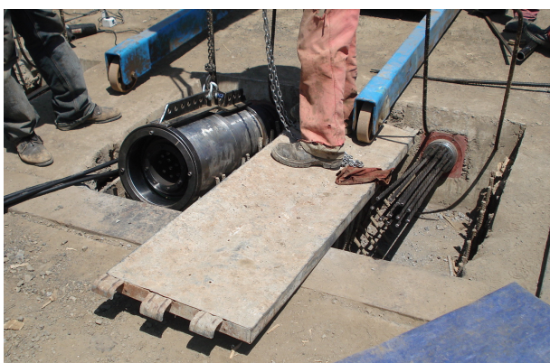
Figura 16 - Gli ancoraggi di testata in soletta
