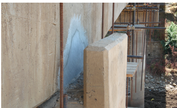
Figura 15 – Particolare del risanamento del calcestruzzo della trave sulla pila centrale
