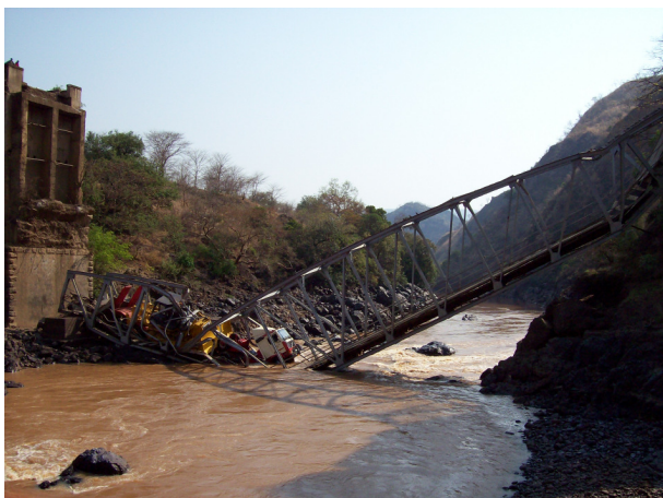
Figura 2 – L'attraversamento adiacente crollato recentemente
