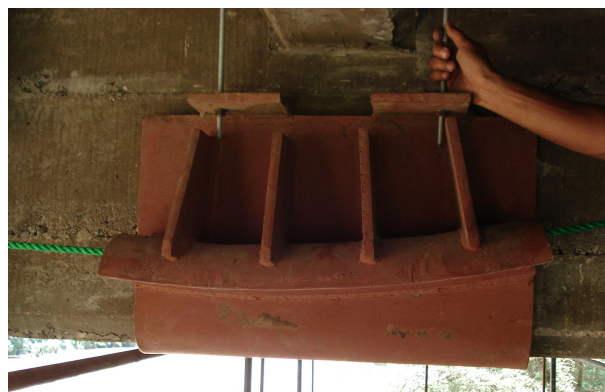
Figura 10 – La sella di deviazione appoggiata alle travi longitudinali (Cavi Tipo A)
